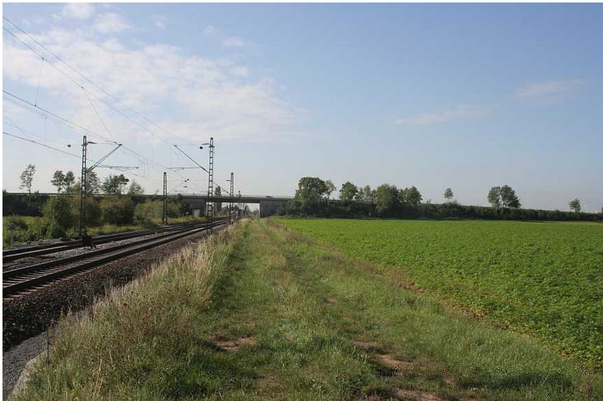
Abbildung 1: Blick von Südosten auf die Fläche, den Bahndamm und den §§ 32-Biotop
